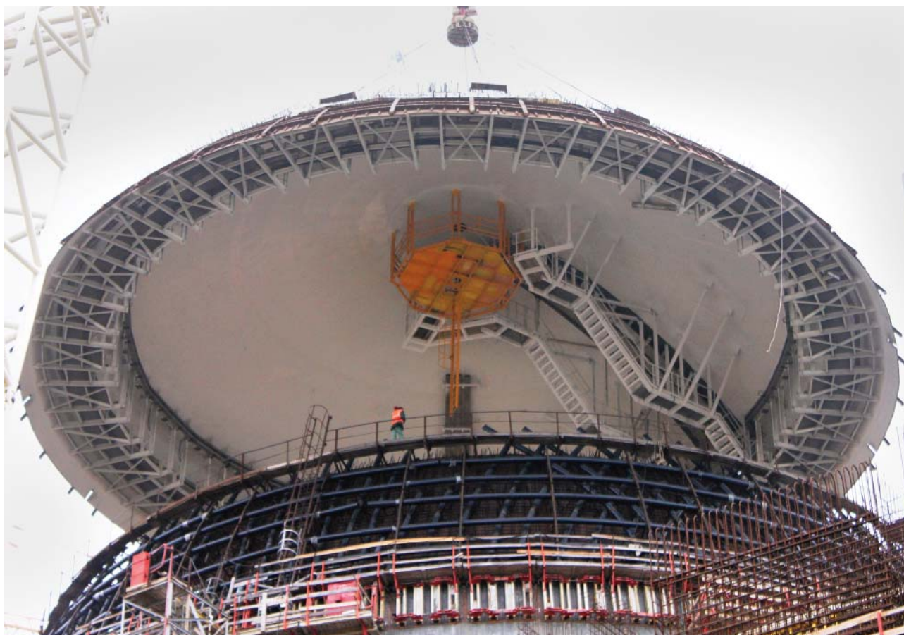
Установка купола реакторного здания вто- рого энергоблока Нововоро- нежской АЭС-2, ноябрь 2014 г.
