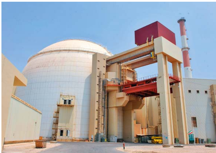
Первый энергоблок Бушерской АЭС, Иран
